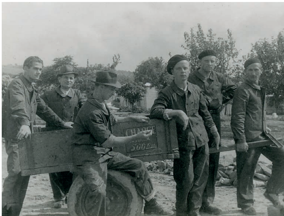
Podczas pracy na stadionie, rozwożenie żwiru i kamieni, fot. por. J. Kowalski
