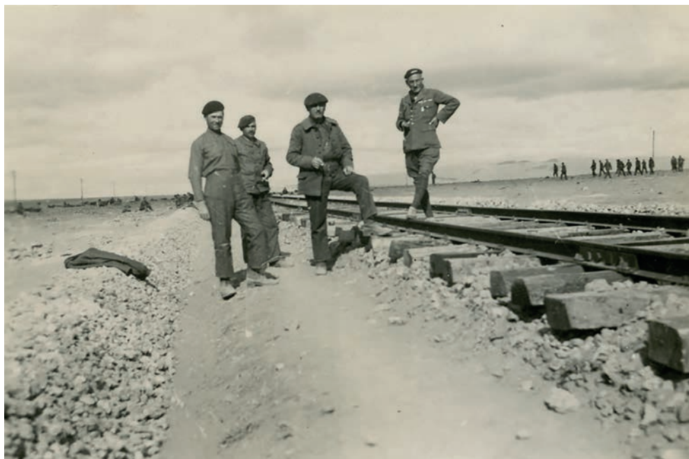
Przy torze kolejowym, stoją od prawej: adiutant Pospiszał (kier. robót), st. sierż. Alojzy Porwoł (zastępca dow. II Plutonu), sierż. Stanisław Czarnota, szef kuchni, wachm. Romuald Gazdecki (zastępca dow. III Plutonu), fot. st. sierż. R. Benal
